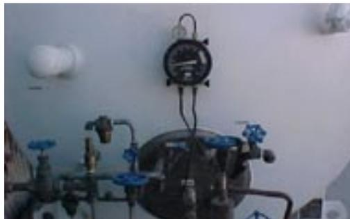
Sist. Control de Nivel y Válvula de llenado Estanque
