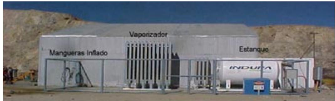
Estación de Inflado con Nitrógeno
